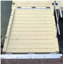
Fixation de la passerelle à la berge
