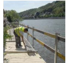
Poteau de garde-corps en aluminium pour travaux de maintenance
