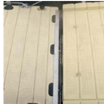
Fixation de la passerelle au ponton
