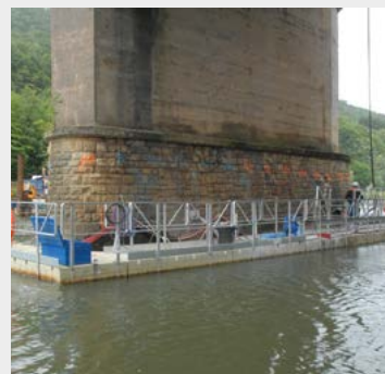
Travaux de maintenance
