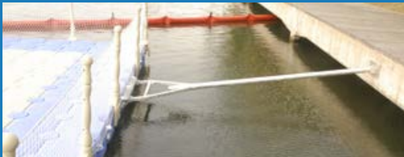
Verankering met dubbelgelede bevestigingsbeugel
